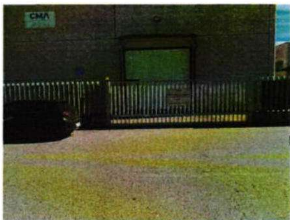
Foto 47 Accesso carraio snc
