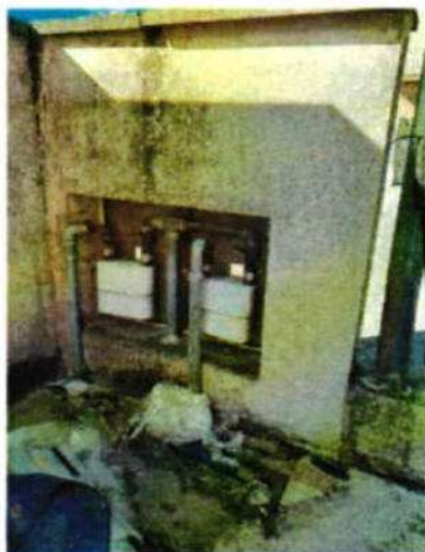
Foto 44 Nicchie con contatori metano
