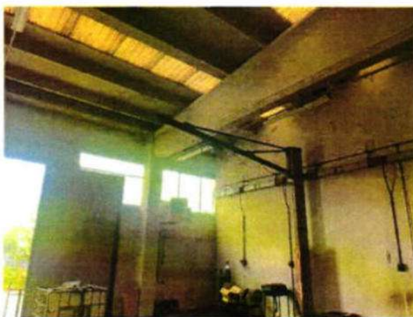
Foto 3 particolare capriata e manto
