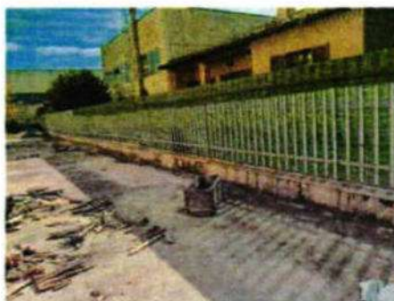
Foto 51-52 Stato di manutenzione
