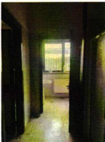
Foto 17 anti wc 1 e disimpegno 2
