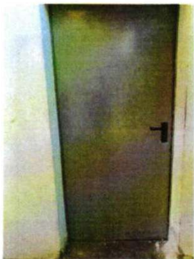
Foto 22 porta accesso spogliatoio 2
