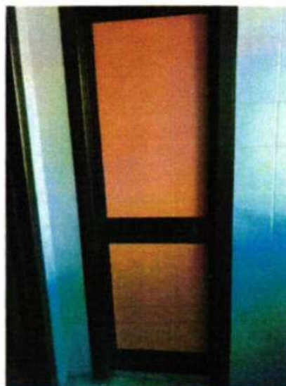
Foto 23 porta particolare servizi
