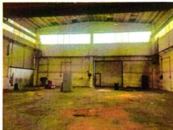
Foto 10 vista carpenteria, capriata, portone, tegoli, pilastri
